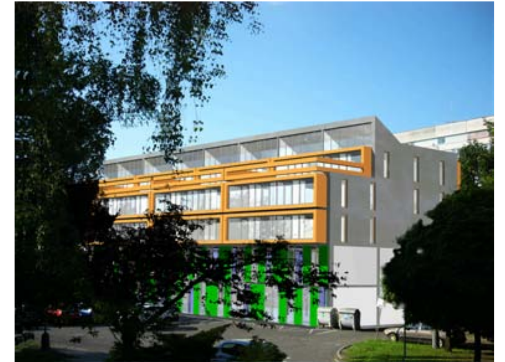
pohled od jihu
